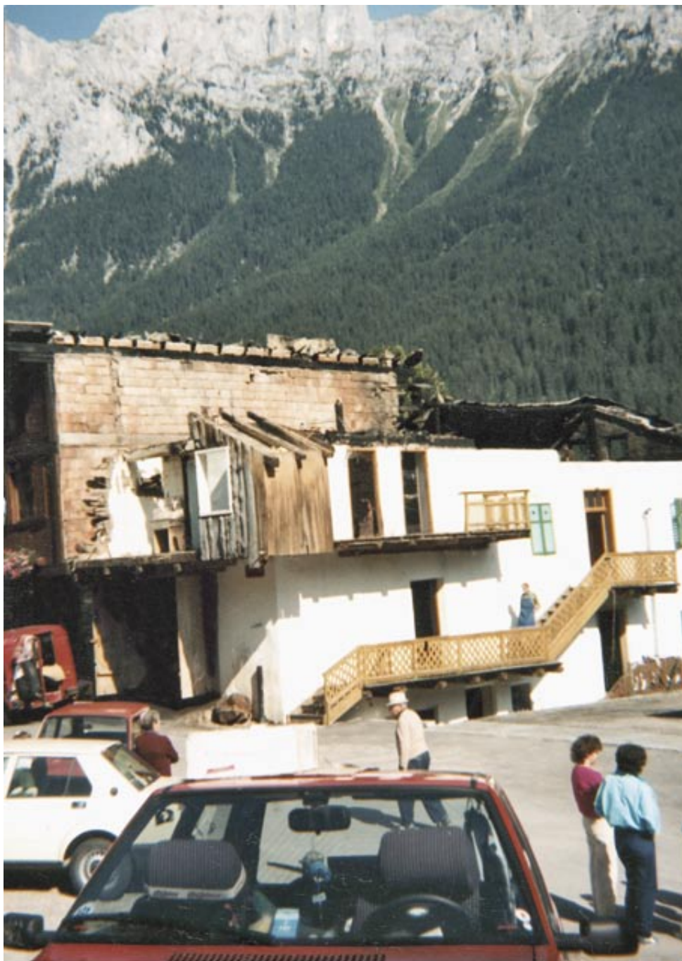
Settembre 1986 - Incendio Renato Zulian Zester (per surriscaldamento di una canna fumaria)
